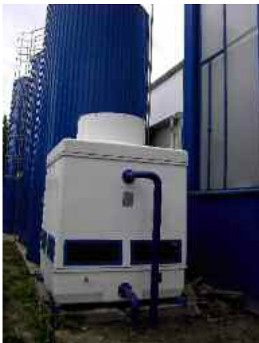
Fot.2. Chłodnia wentylatorowa produkcji polskiej, wykonana z tworzywa sztucznego. Archiwum autora.
