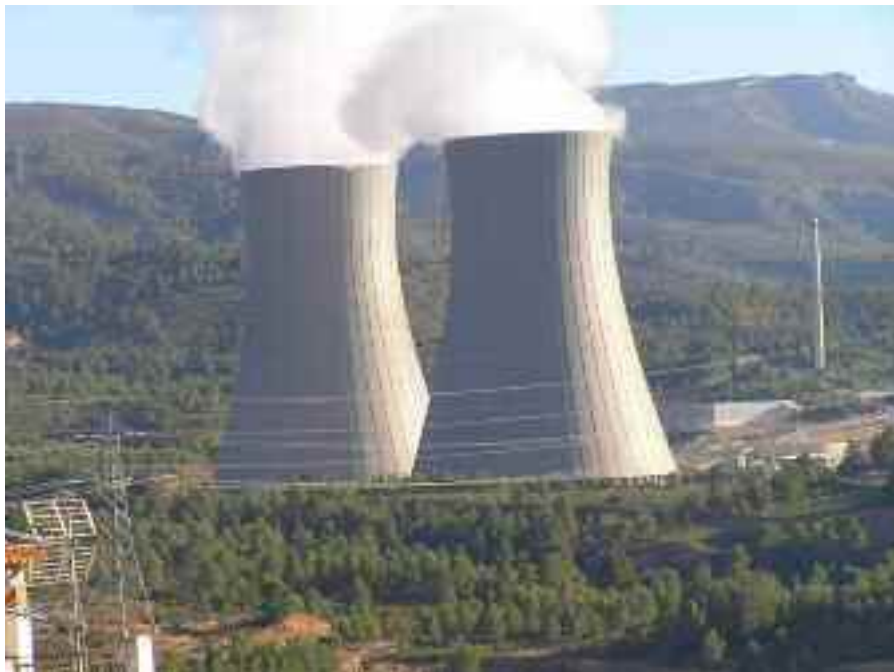
Fot. 1. Zdjęcie wież chłodniczych o naturalnym ciągu elektrowni jądrowej w Cofrentes w Hiszpani. fot. Roberto Uderio 32 .
